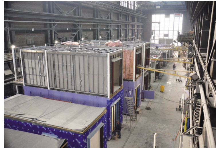
Carmel Place, el primer edificio de departamentos con microunidades de Nueva York, presenta unidades modulares construidas en un espacio fabril en Brooklyn Navy Yard (izquierda) y luego ensambladas en el sitio, en un terreno que se creía demasiado pequeño para una construcción tradicional (derecha). Crédito: nArchitects.
