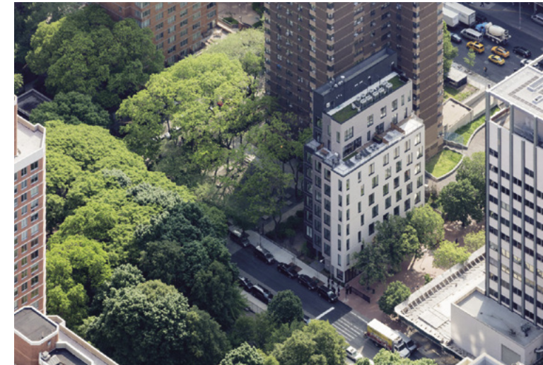
Carmel Place, el primer edificio de departamentos con microunidades de Nueva York, presenta unidades modulares construidas en un espacio fabril en Brooklyn Navy Yard (izquierda) y luego ensambladas en el sitio, en un terreno que se creía demasiado pequeño para una construcción tradicional (derecha). Crédito: nArchitects.
