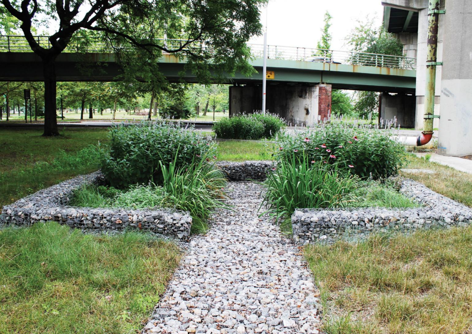
Un sistema de Detención Natural de Puente de Autopista (HOLD, por su sigla en inglés) es un elemento de biofiltración que se puede desplegar debajo de infraestructura elevada para filtrar y retener el exceso de agua de tormenta. Fotografía cortesía de DLANDstudio Architecture + Landscape Architecture, PLLC.
