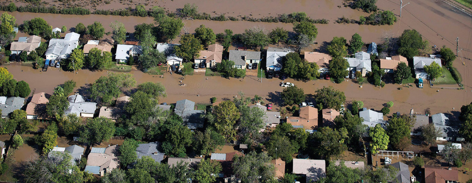
En 2013, las inundaciones súbitas afectaron a cientos de familias en Dove Springs y otros barrios de Austin, Texas. Al día de hoy, la ciudad compró y demolió 800 propiedades que corren riesgo de inundación crónica. Crédito: Austin American-Statesman/USA TODAY Network .
