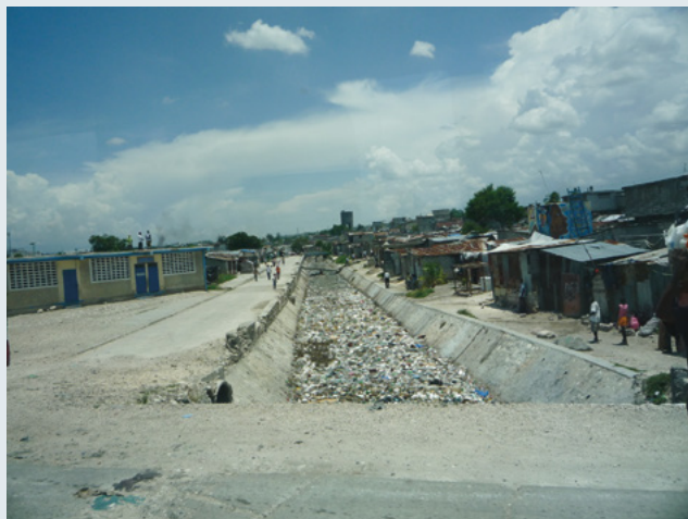
Assentamento construído próximo a áreas tóxicas, Puerto Príncipe, Haiti
