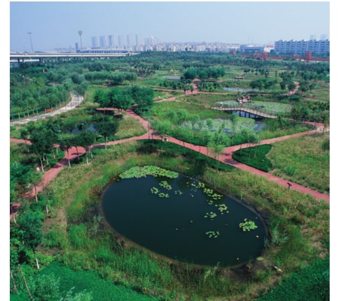
En el lugar donde había un basurero municipal en la ciudad de Tianjin, China, el parque de humedales Tianjin Qiaoyuan de Turenscape cuenta con senderos peatonales pavimentados y una laguna de agua de lluvia diseñada para irrigar la vegetación que rehabilita el suelo salino-alcalino. Fotografía de Kongjian Yu.
