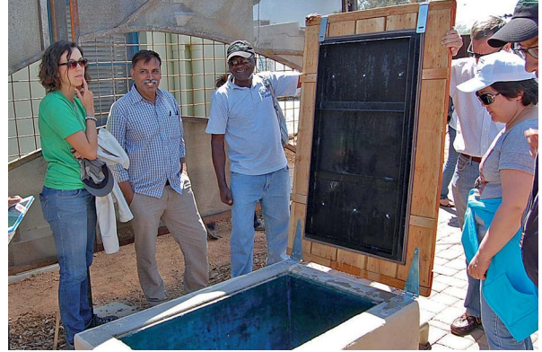
En el Laboratorio Vivo y Centro de Aprendizaje de Watershed Management Group, en Tucson, los visitantes echan un ojo a la cisterna subterránea de 45.000 litros que la organización usa para capturar y almacenar agua de lluvia. Crédito: Watershed Management Group, watershedmg.org.
