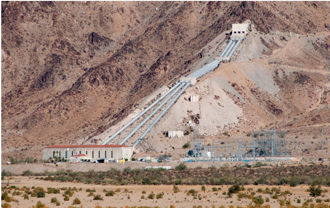
Una estación de bombeo de California envía agua del río Colorado cuesta arriba en su largo viaje hasta Los Ángeles. Crédito: NNehring vía iStock.
